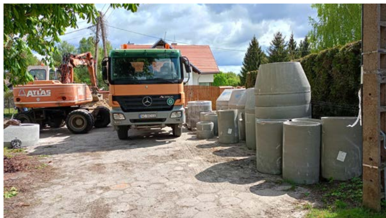
Na przebudowę ul. Barczewskiego mieszkańcy czekali wiele lat
