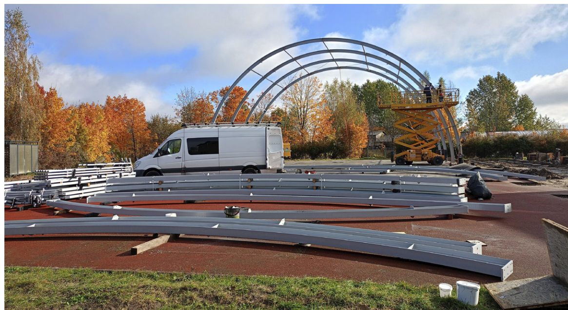
Dzięki pracom związanym z wykonywaniem konstrukcji pojawiły się pierwsze zarysy zadaszzonego boiska w Dywitach
