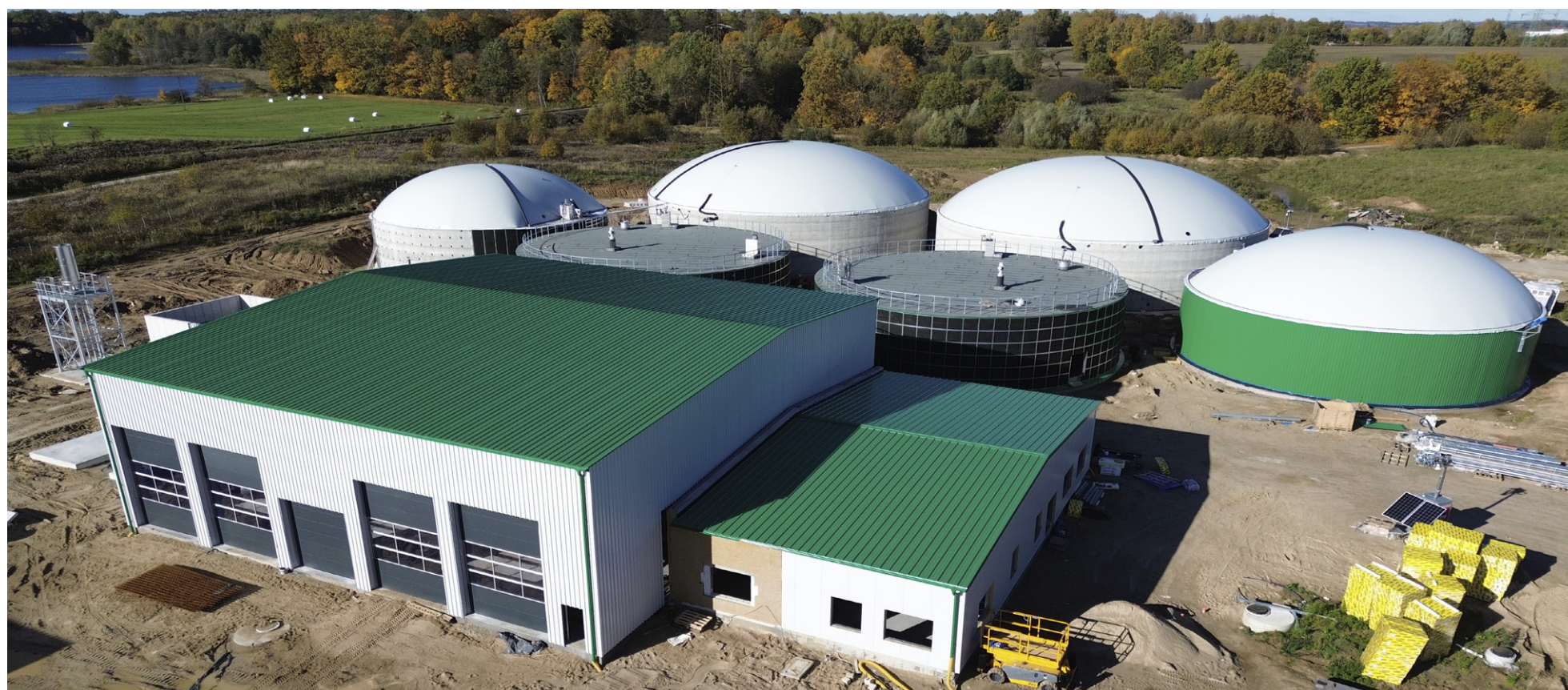
Budowa biogazowni komunalnej ZGOK
