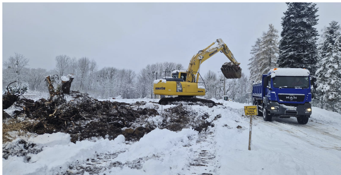
Mimo zimowej aury prace przy budowie pętli autobusowej i parkingu w Spręcowie mocno ruszyły
