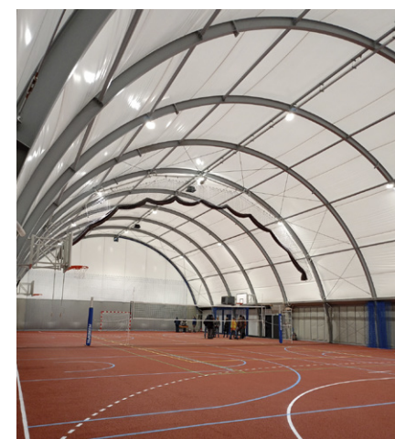
Odbiór techniczny nowego zadaszania hali przy SP Dywity ruszył dwa dni przed końcem 2025. Wkrótce z obiektu będą mogli korzystać uczniowie i mieszkańcy
