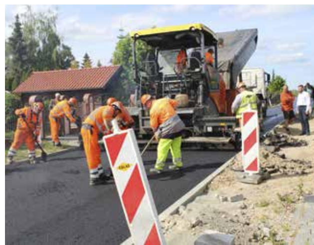
Prace bitumiczne związane z układaniem ostatniej warstwy tzw. „ścieralnej” trwały kilka dni
