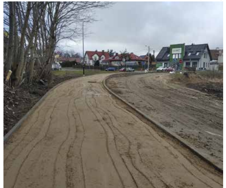
Na zakończenie budowy ul. Warmińskiej czekają mieszkańcy osiedla Kormoran w Dywitach
