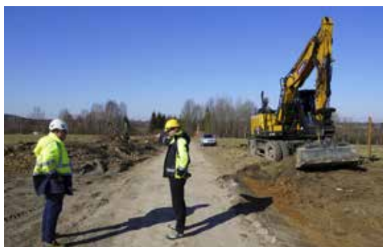
Ruszyła długo wyczekiwana inwestycja drogowa za 10 milionów złotych, czyli przebudowa drogi Dągi-Różnowo, która jest niejako kontynuacją zmodernizowanej już drogi na odcinku Kieźliny-Dągi
